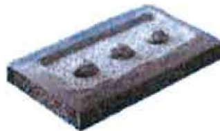
Abbildung 1. Auftragen des Klebers auf die Wärmedämmplatte
